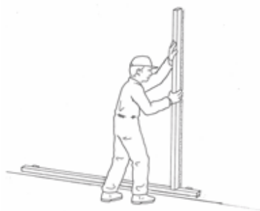
Figs. 6 y 7. Se aplica la pasta de Onegyps® YP sobre las reglas.
